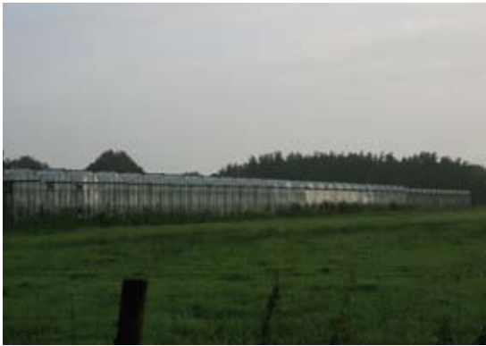
Ondersteunend glas op of aansluitend aan het agrarisch bouwvlak, meestal volstaat een goede ruimtelijke inpassing. Liever niet zo!
